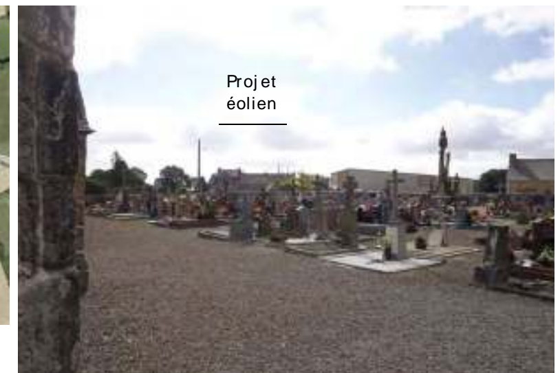
MH 61 - Eglise de Gurunhuel et calvaire du cimetière : végétation et bâti de second-plan ferment les vues en direction du projet
