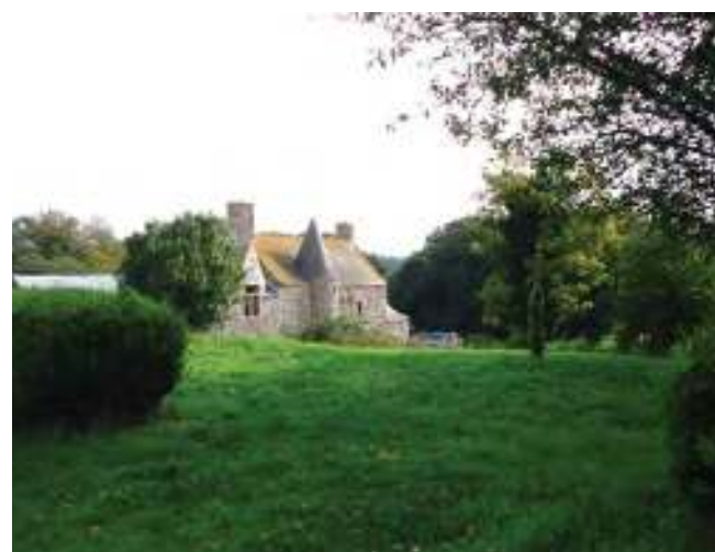
(d) - Manoir de Trolan implanté dans un environnement boisé, au contact de la ZIP
